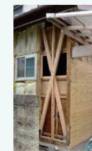
耐震補強工事
