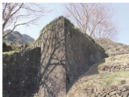
小島陣屋跡 大手石垣
