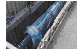
耐震化された水道管
